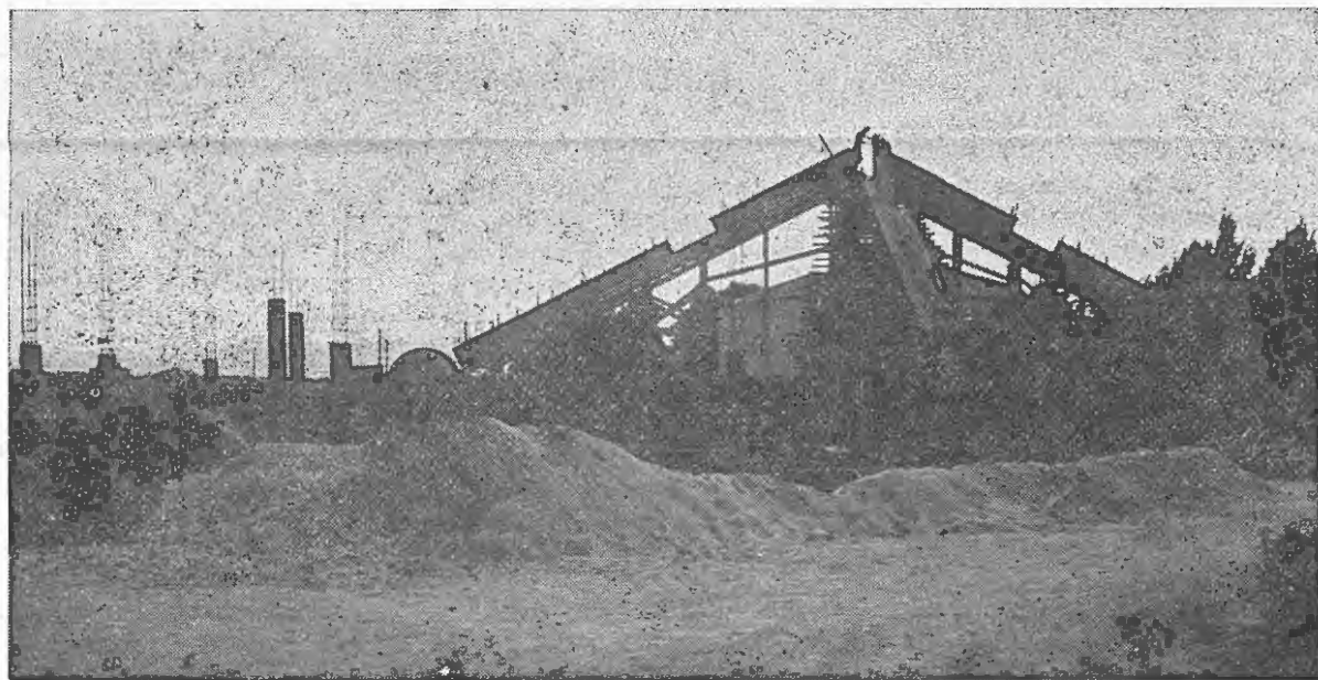
Dar o pão suficiente e também o do Espírito são imperativos da nossa missão. Por isso, eis mais um aspecto das obras da Capela, em Santo António do Tojal.
